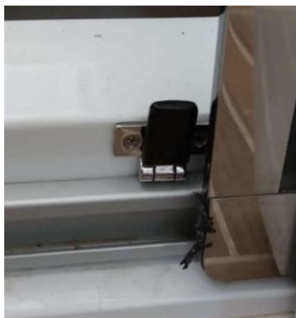
FIG. 4.7-1 - Sliding door lock
